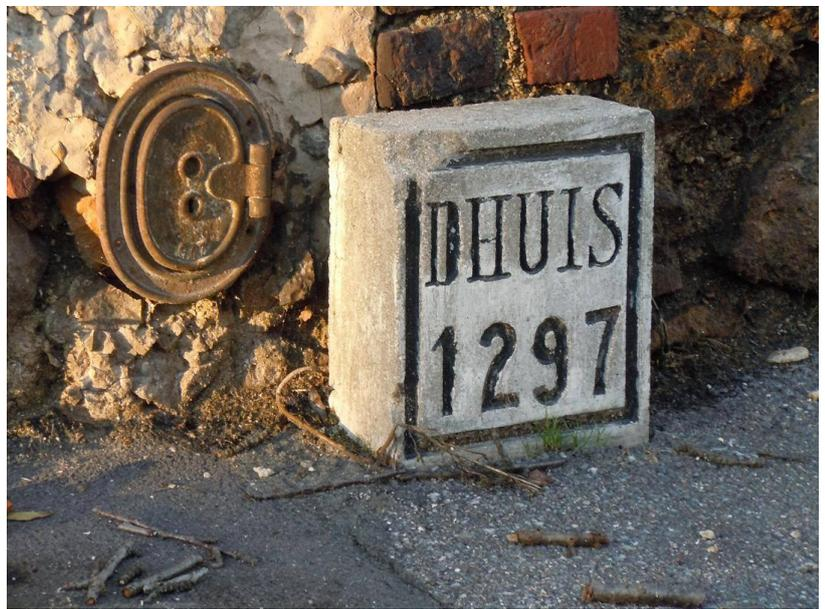
point de départ de l'aqueduc, à Pargny-la-Dhuys (Aisne), est à une altitude de 128 m pour arriver à 108 m dans le réservoir de Ménilmontant (Paris).
